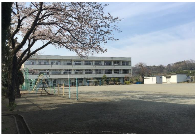
図4 現在の湘南小学校（校舎右側の崖下に相模川H29.4）S
