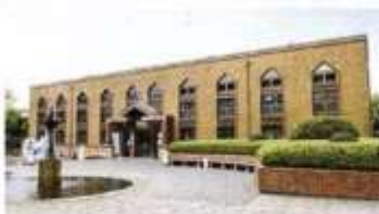
日本最初の広域水道であり、昭和11年に送水ポンプが設置された
