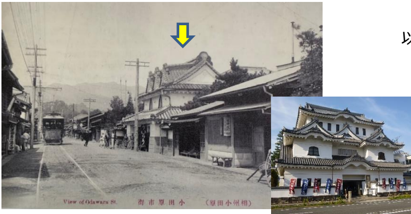
明治時代の絵葉書に見られる外郎の店舗。この建物は関東大震災で倒壊（現在の店舗が右）。小田原市内の旧東海道を走る小田原電気鉄道が写っている（左側）。
