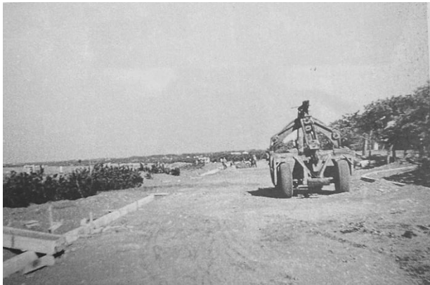
“湘南遊歩道”の改修工事風景(昭和30年)。 “湘南遊歩道”は昭和28年に国道134号に指定される
